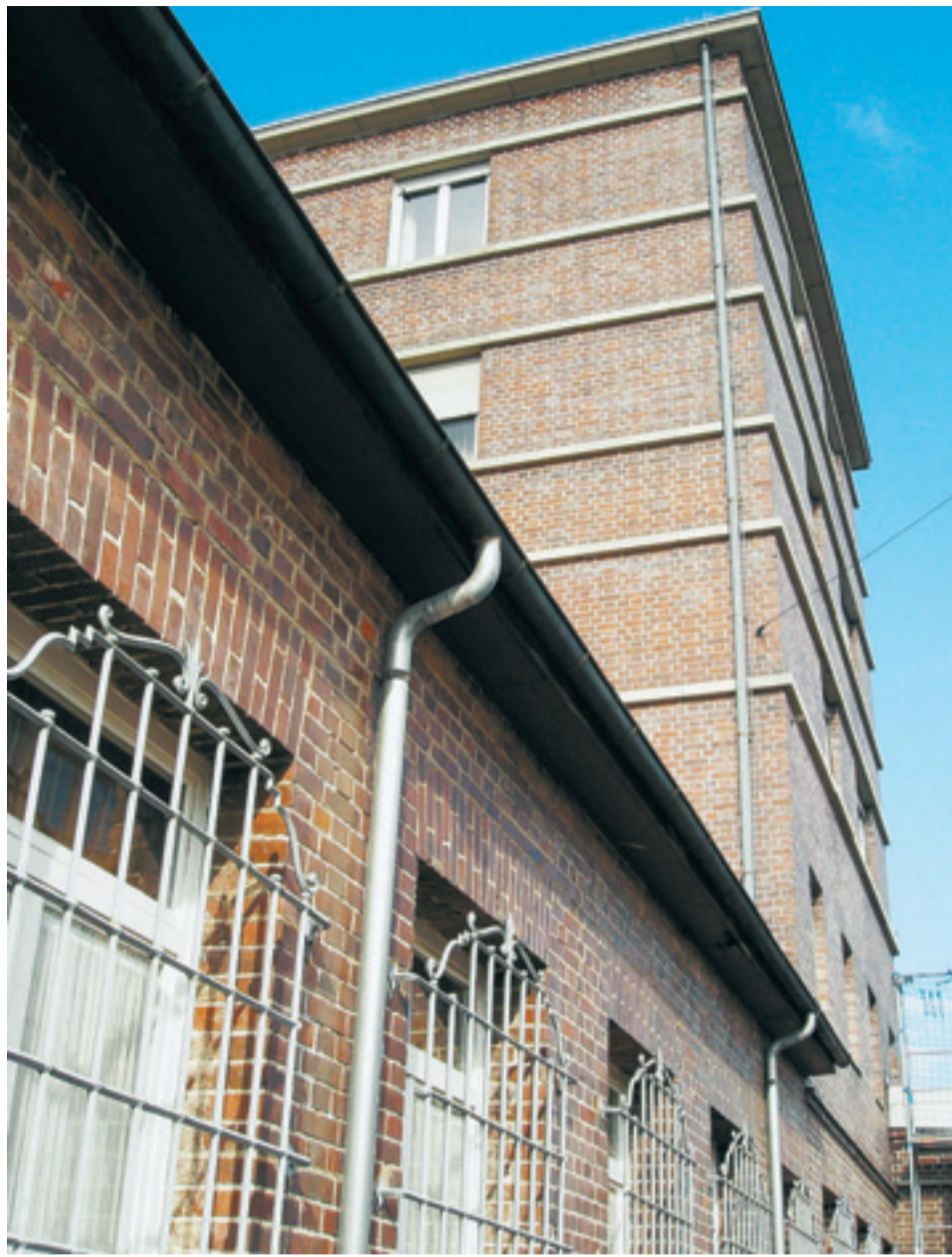
Besonderes Merkmal des Betriebshofs in Bad Cannstatt ist die Ziegelbauweise.
